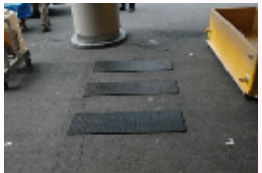
水槽設置場所にゴムマットを敷く
